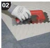
Extender sobre el soporte en paños pequeños y peinar con una llana dentada de 8x8 mm para regularizar el espesor de la aplicación.
