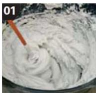
Amasar **weber.col lanic confort** con 7,5-8,5 litros de agua limpia por saco de 15 Kg., con un batidor eléctrico lento (500 rpm), hasta obtener una masa homogénea y exenta de grumos.
