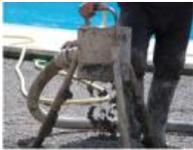
Amasar arcilla expandida **Arlita® Leca® light plus** con un 10-20% de agua y un 15-30% de cemento, y verter o bombear\* sobre el soporte.
