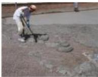
Extender el mortero con un espesor mínimo de 3 cm, regleándolo sobre maestras recuperables.
