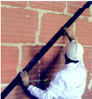
Colocación sobre super-tabique.
