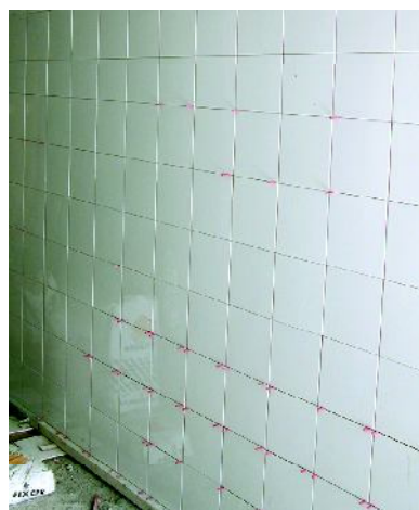
Colocación de azulejos sobre revoques de yeso.
