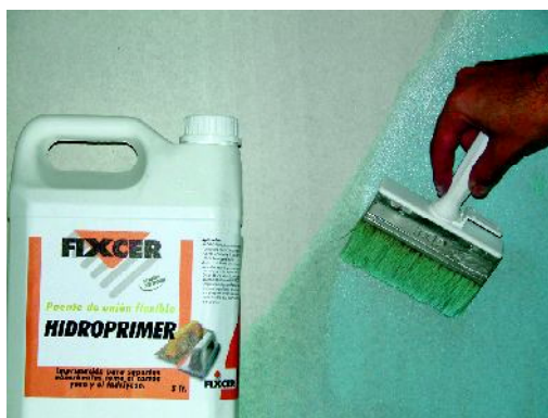
Imprimación con HIDROPRIMER.
