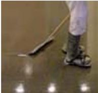
Dejar reposar la mezcla 2 minutos y extender **weber.floor durolit** en el espesor deseado con una llana de dientes.
