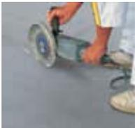
Realizar los cortes con la radial cuando el material aún esté semirígido. Si se espera a su fraguado total se deberá emplear equipos avanzados de esmerilado.
