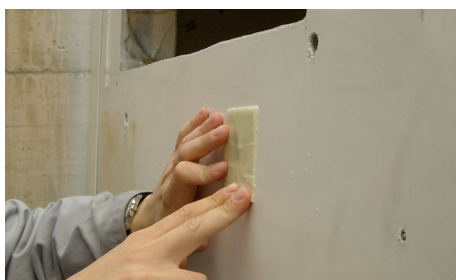
Reparación de una fisura en un panel de fibra
