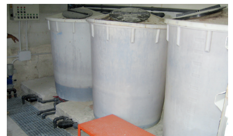
Reparación de una fisura en un depósito de líquidos
