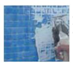
1) Aplicar una primera capa de regularización con Pavicem Grueso a razón de 0.5 – 1 mm de espesor.
