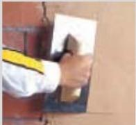
Amasar **weber.pral arid** con 7.5 – 9.5 litros de agua limpia por saco, manualmente (a batidora) o mediante la máquina de proyectar. Extender el producto con llana de proyectar sobre el soporte creando cordones, y reglarlo para regularizar el espesor, hasta conseguir un mínimo por capa de 8 mm y un máximo de 16 mm (en dos capas).
