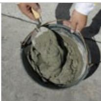
Amasar con 1 parte de agua por cada 4 partes de **weber.rev base coat gris** ( 1.8 a 1.9 litros de agua por cada 10 kg de materia)l
