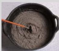
Amasar a mano o con un batidor mecánico lento (500 rpm), un saco de 25 kg con 4 – 4,5 litros de agua limpia.
