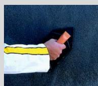
El acabado se puede realizar con fratás o esponja, según la textura deseada. Para un correcto curado, es muy importante mojar la superficie impermeabilizada 24 horas después de la aplicación, y repetir la operación durante 4 días.
