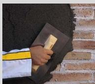
Sobre el soporte húmedo. Extender el producto a llana y reglearlo, siendo el espesor final de 10 mm, como mínimo, en cualquier punto. Para aplicaciones superiores de 10 mm de espesor, aplicar capas sucesivas de 5 a 10 mm.
