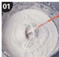
Amasar **weber.col dur confort** con 7-8 litros de agua limpia por saco de 15 kg, con un batidor eléctrico lento (500 rpm), hasta obtener una masa homogénea y exenta de grumos.
