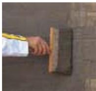
Aplicar una primera capa de **weber.tec imperflex** usando una brocha o llana con un espesor máximo por capa de 2 mm.
