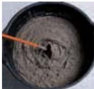
Amasar con un batidor eléctrico lento (500 rpm), con 3,15 – 3,45 litros de agua por cada saco de 15 kg, hasta obtener una mezcla homogénea y fluida, con consistencia de pintura.
