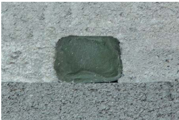
Colocar embutido en hormigón.
