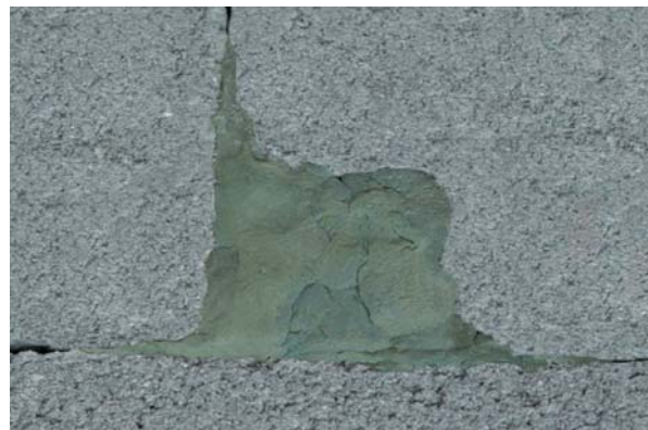
Expande sellando la fisura.
