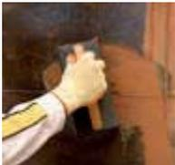
Rellenar las juntas con una llana de caucho, extendiendo el producto en diagonal a las juntas y presionando la masa sobre ellas. Puede utilizarse, también, una pistola rellenable.
