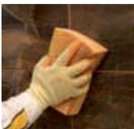
Una vez iniciado el endurecimiento, cuando desaparezca el brillo superficial del mortero de juntas, podrá limpiarse con una esponja húmeda. La limpieza final debe hacerse con el producto completamente endurecido (mínimo 24 horas), enjuagando la superficie con agua limpia o con un paño humedecido.
