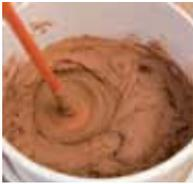
Amasar **weber.color flex** con 4,5 - 5,5 litros de agua limpia por saco de 25 kg, manualmente con un batidor eléctrico lento (500 rpm), hasta conseguir una masa homogénea. Dejar reposar la mezcla 2 minutos.
