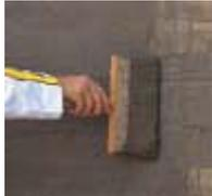
Aplicar **weber.tec imper F** en dos capas, usando una brocha o llana, sobre el soporte humedecido. Aplicar una primera capa de, como mínimo, 1mm de espesor (1,5 kg/m<sup>2</sup>) y dejarla secar 4 horas.
