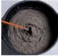
Amasar con un batidor eléctrico lento (500 rpm), con 6,25 – 6,75 litros de agua por cada saco, hasta obtener una mezcla homogénea y fluida, con consistencia de pintura.
