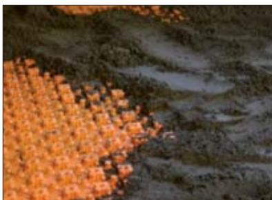
14 Einbau des Estrichmörtels ohne Bewehrung und Bewegungsfuge. Ausnahme: im Türbereich, mit Kellenschnitt oder Dehnfugenprofil Schlüter®-DILEX-DFP sowie Bauwerkstrennfugen.
