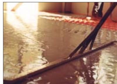
16 Alternativ zu 14 und 15 : Einbringen eines Fließbestrichs auf Estrichplatte Schlüter®-BEKOTEC-EN 23 F. Um eine planebene Oberfläche zu erzielen, eignet sich z. B. das Schwabbeln mit einem groben Besen oder Schwabbelstange.
