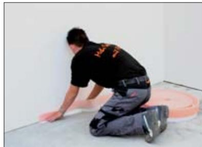
2 Einbau des Randstreifens BRS 808 KSF mit Klebestützfuß.
