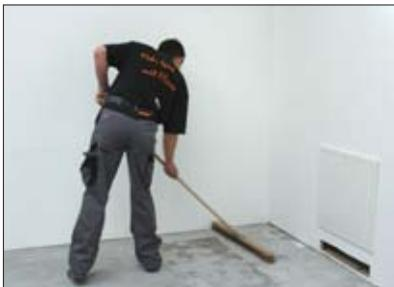
1 Reinigen des ausreichend tragfähigen und ebenflächigen Untergrundes.
