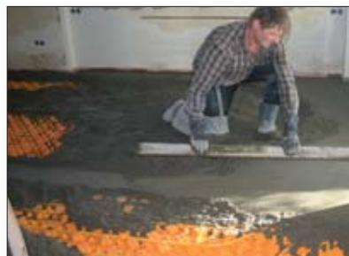
15 Abziehen der Estrichfläche mit einer Mindestüberdeckung von 8 mm. Höhenausgleich bei bereichsweisen Unebenheiten max. 25 mm Estrichüberdeckung.
