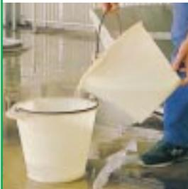
Verter en un cubo limpio 10 l de agua potable a 35 - 38 °C. Evitar las aguas cloradas.
