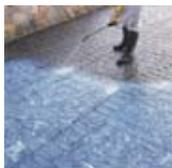
Aplicar dos manos de la resina protectora y de acabado **weber SL**, mediante pulverizado o rodillo.
