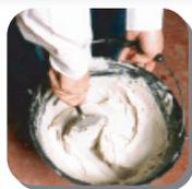
**1.** Se prepara en balde de albañil colocando primero el agua. Usar 5.5 – 6.5 litros de agua por cada bolsa de 25 Kg, mezclando hasta conseguir una mezcla homogénea y sin grumos.
