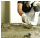
Fratasar sin agregar agua. De ser requerido, alisar con llana metálica blanda, siguiendo la condición de no agregar agua. El piso cementicio estará en condiciones de ser sellado con dos manos de weber protector de pisos aproximadamente a la semana de aplicado. A las 24 hs. podrá ser transitado con cuidado.
