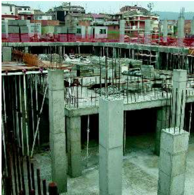
Aplicable en todo tipo de estructuras, para unir de forma monolítica diferentes hormigones.
