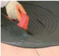
Dejar reposar la mezcla 2 minutos y verter posteriormente sobre el soporte. Extender una capa fina de material apretando con la parte lisa de la llana, y seguidamente peinar con la llana dentada de 10x10 mm para regularizar el espesor.
