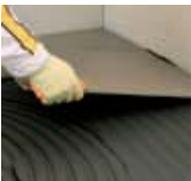
Colocar las baldosas, presionarlas y moverlas de arriba abajo, hasta conseguir el aplastamiento de los surcos. Limpiar las manchas de producto sobre la cerámica con una esponja húmeda a medida que se aplica.
