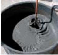
Amasar **weber.col fluid** con 6,5 - 7 litros de agua limpia por saco, manualmente o con un batidor eléctrico lento (500 rpm), hasta obtener una masa homogénea.
