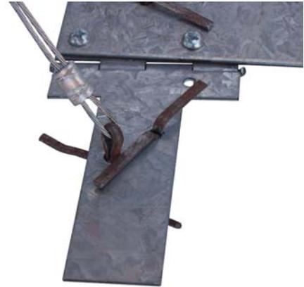
8. Enganchar el otro extremo del cable de acero en la chaveta libre de la bisagra.
