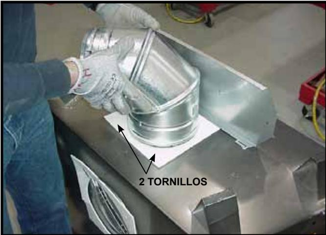
Figura 22. A la hora de instalar la primera sección del tubo, asegúrese de usar la empaquetadura de fibra de vidrio para sellar la brecha entre la primera sección de tubo y la parte superior de la chimenea. Utilice 2 tornillos autoperforadores para sujetar la empaquetadura.
