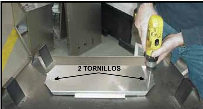
Figura 16. Para ventilar la chimenea por arriba, retire los dos tornillos que sujetan el escudo térmico superior. Para ventilar por atrás, consulte la siguiente página.
