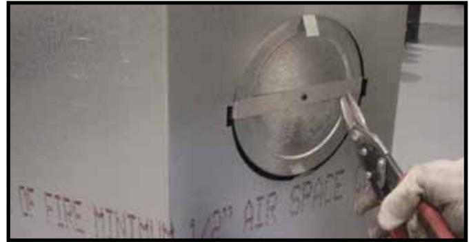
Figura 24. Corte la banda retenedora y dóblela hacia afuera.
