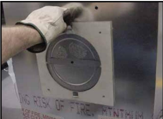
Figura 23. Doble las lengüetas hacia el centro de la tapa selladora y retire la empaquetadura de fibra de vidrio.
