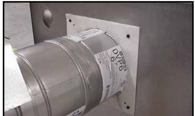
Figura 27. Una la primera sección de tubo a la chimenea. Coloque la empaquetadura alrededor del tubo y deslícela sobre las lengüetas hasta topar con la chimenea. Utilice 2 tornillos autoperforadores para sujetar la empaquetadura.
