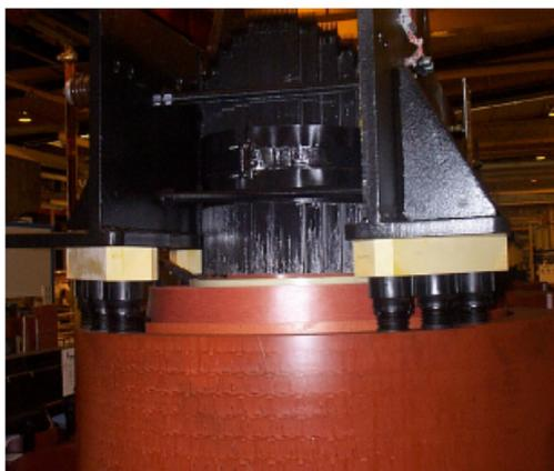
Para limitar el impacto de estas fuerzas vinculadas con el transporte, el transformador debe estar colocado con su eje longitudinal paralelo al sentido de la marcha.
