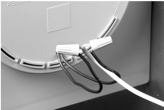
Fig. 49. Raccordement du moteur.
