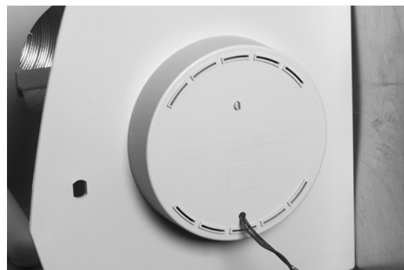
Fig. 22. Installation du couvercle du moteur.
