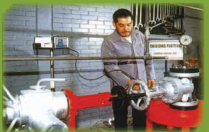
Medición de emisiones con gas Helio, pruebas de apertura y cierre de hasta 1000 ciclos.
