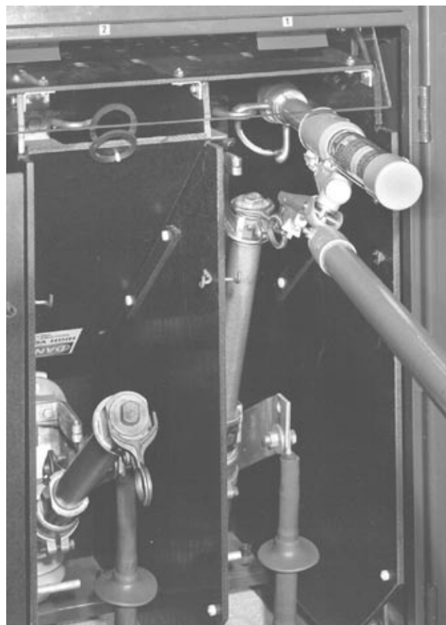
Figura 12. Desenganche de la Loadbuster de un fusible de potencia.
