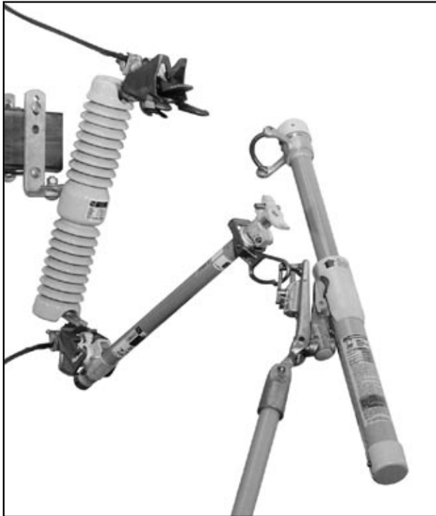
Figura 7. Desenganche de la Loadbuster del fusible de potencia.
