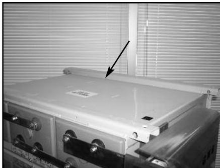
Figura 4: Ubicación recomendada para la conexión a tierra del bastidor
