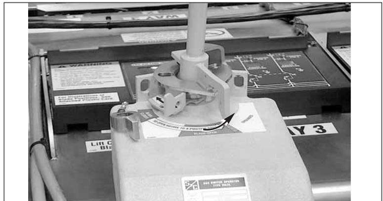
Figura 18. Conexión a tierra del seccionador interruptor de carga (o interruptor de falla).
