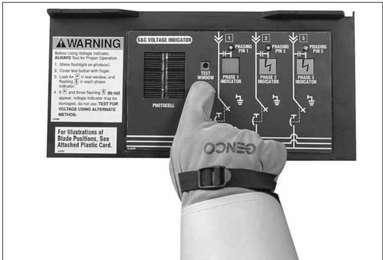
Figura 46. Si uno o más indicadores de fase no muestran una flecha en forma de rayo parpadeante durante la prueba, el indicador de voltaje podría estar dañado. Verifique el voltaje utilizando un método alterno.
