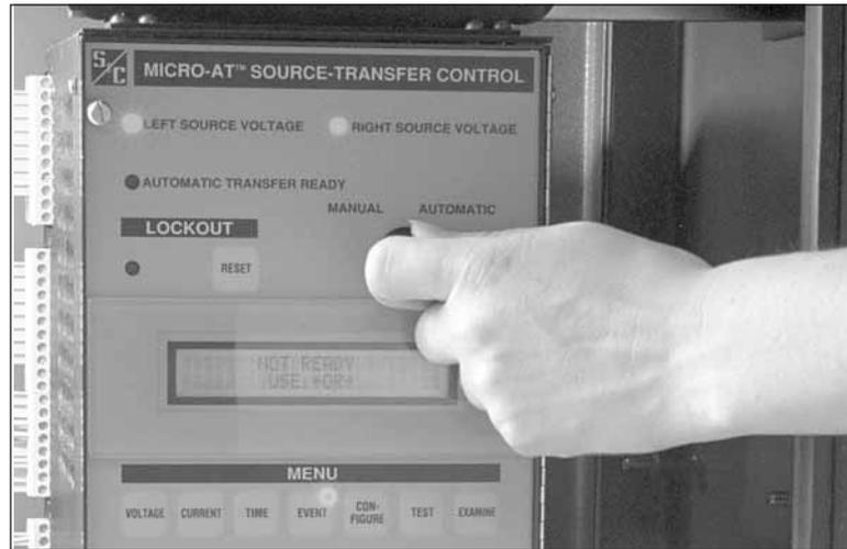
Figure 23. Interruptor manual/automático del controlador Micro-AT.
