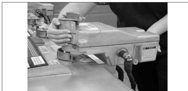
Figura 36. Levantar el moto operador.
