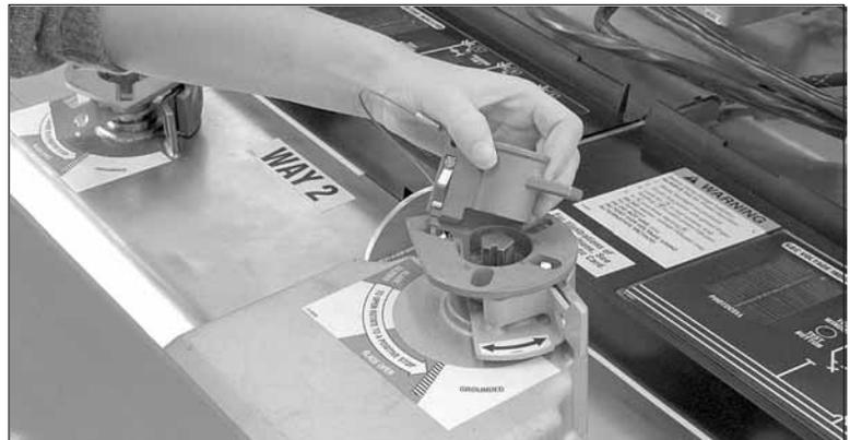
Figura 27. Reemplace el mecanismo de operación eléctrico asegurado con candado.
