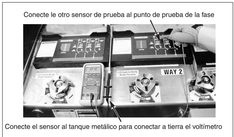
Figura 49. Conecte los sensores de prueba al tanque metálico, para conectar a tierra el voltímetro y al punto de prueba de la fase
