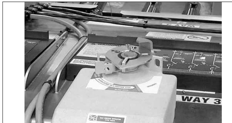
Figura 30. En la posición del extremo izquierdo, el selector de operación permite la operación entre abierto y aterrizado.
