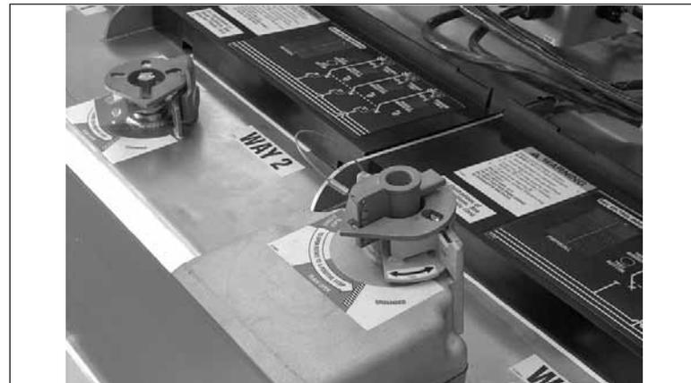
Figure 24. Indicación de posición “abierto” en el moto operador.
