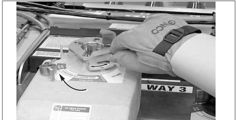
Figura 17. Al girar el selector de operación al extremo izquierdo, permitirá operar a la posición aterrizada.
