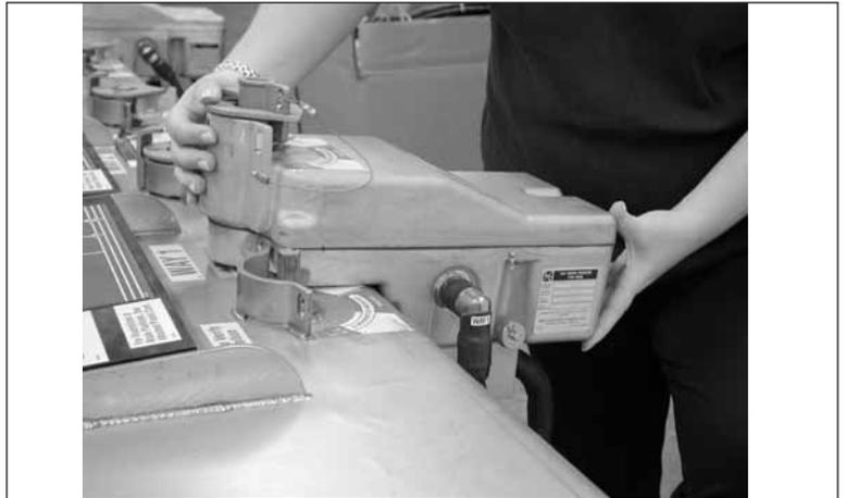
Figura 38. Reposicionar el moto operador.
