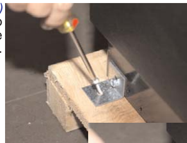
(figura 2) Removiendo el soporte del gabinete.
