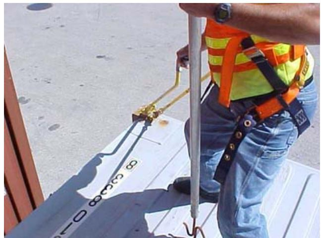
Cuando el vástago esté bloqueado en su posición, el trabajador podrá moverse a la esquina y realizar la tarea necesaria. Al terminar, el trabajador debe moverse hacia atrás y desenganchar el vástago apretando el mango y levantando el vástago fuera de la pieza fundida.
