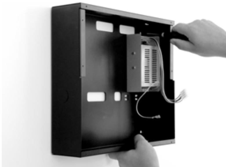
**Figura 10 - Fissaggio della centrale**
