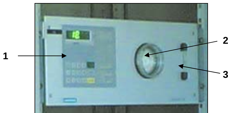
Analizzatore OXYMAT 5E in cabina analisi
