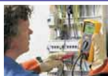
Test d'isolamento su un quadro di distribuzione
