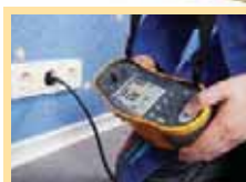
Tester per le verifiche dell'impianto elettrico
