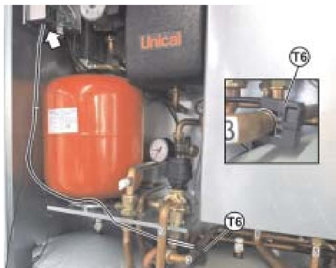
Collegare il connettore "T6" alla sonda "S".
