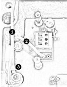
**Immagine 4.6** Alimentazione di rete con schermatura rimossa che mostra il blocco terminale HD1 prima del cablaggio
