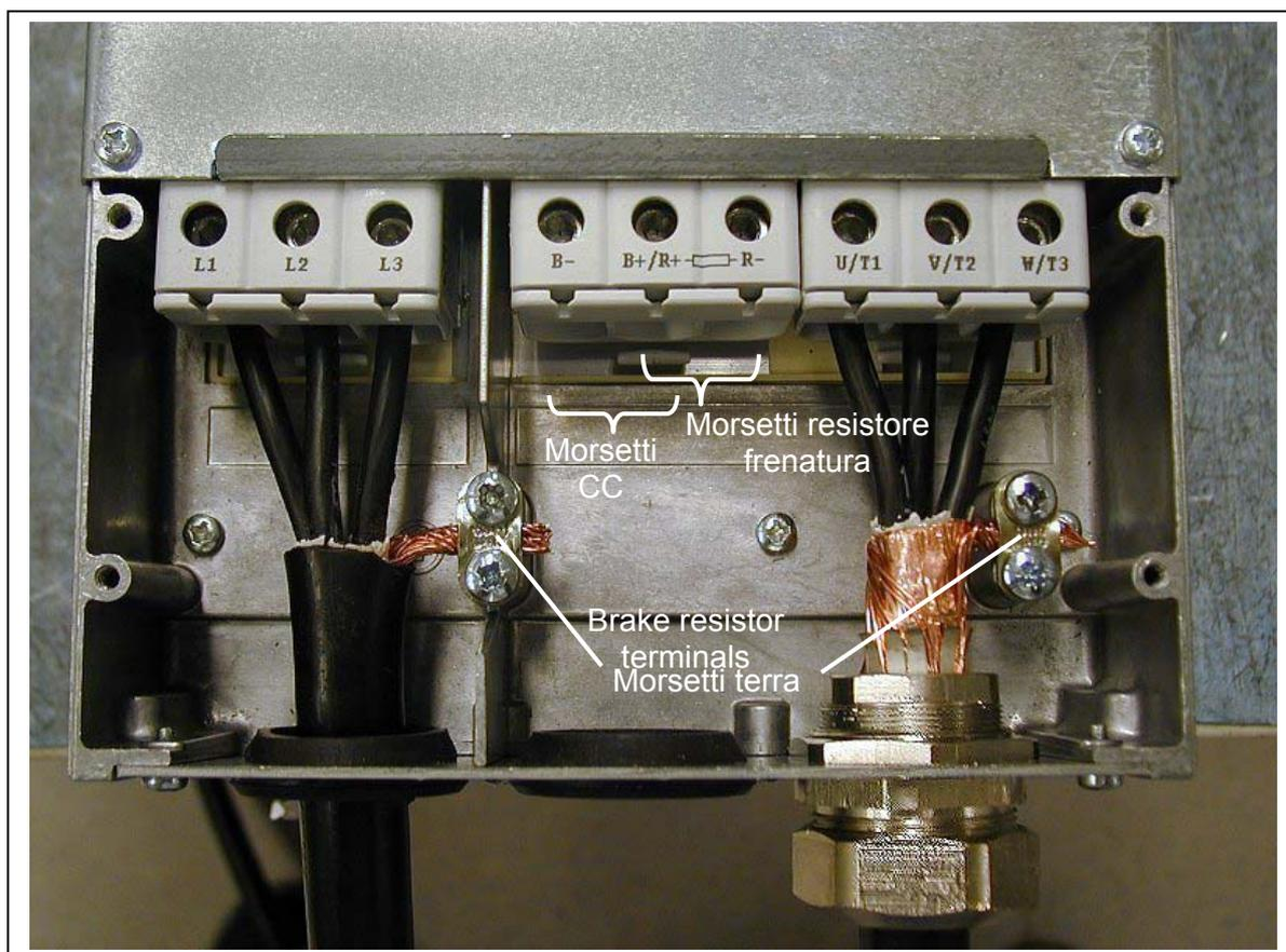
Figura 6-10. Installazione cavi nel Vacon NX, FR6
