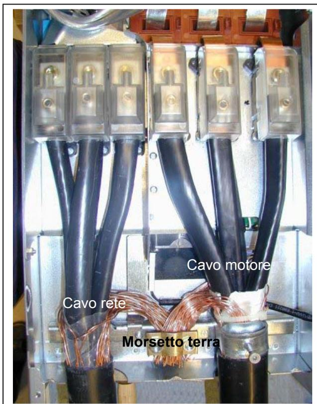
Figura 6-14. Installazione cavi nel Vacon NX, FR8
