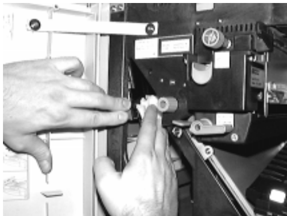
Figura 5-4 Pulizia dell'area di inversione
