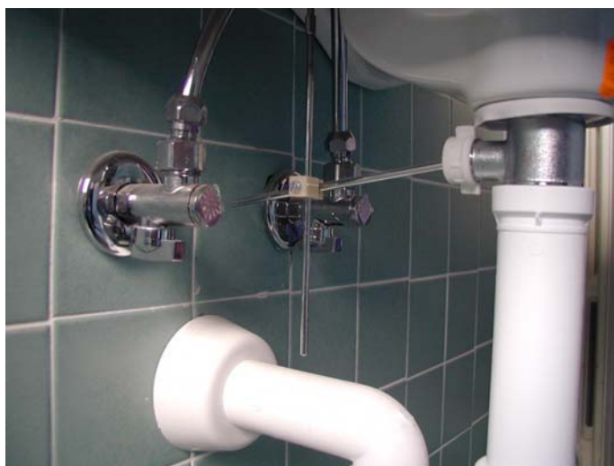
Rubinetti di adduzione di acqua al singolo apparecchio
