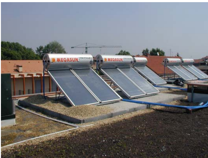
I pannelli solari termici
