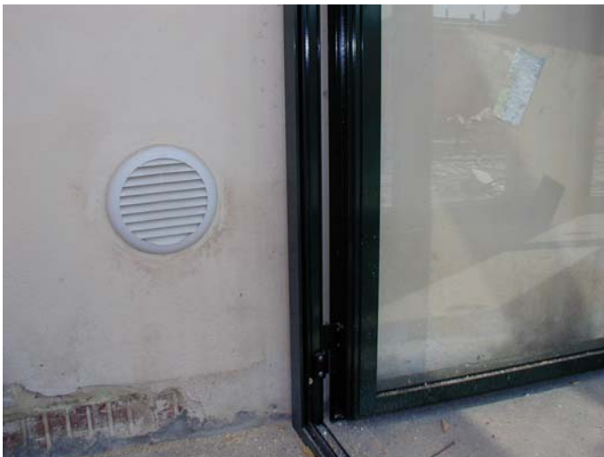
Apertura di ventilazione naturale cucina
