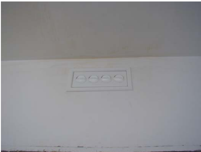
Bocchetta di immissione dell'aria nella camera da letto
