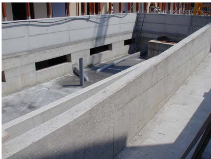
La rampa al di sotto della quale è presente la vasca di raccolta dell'acqua piovana
