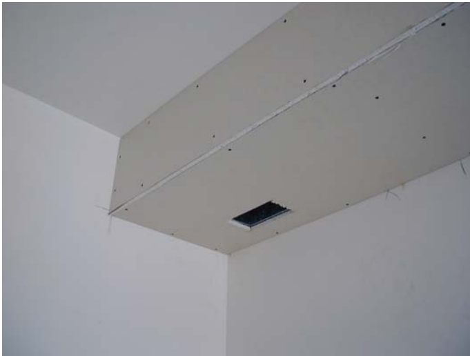
Bocchetta di immissione dell'aria nel soggiorno-cucina
