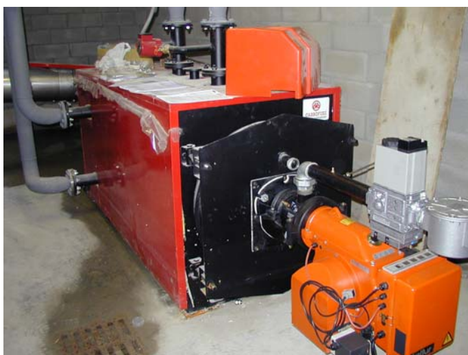
Caldaia a condensazione
