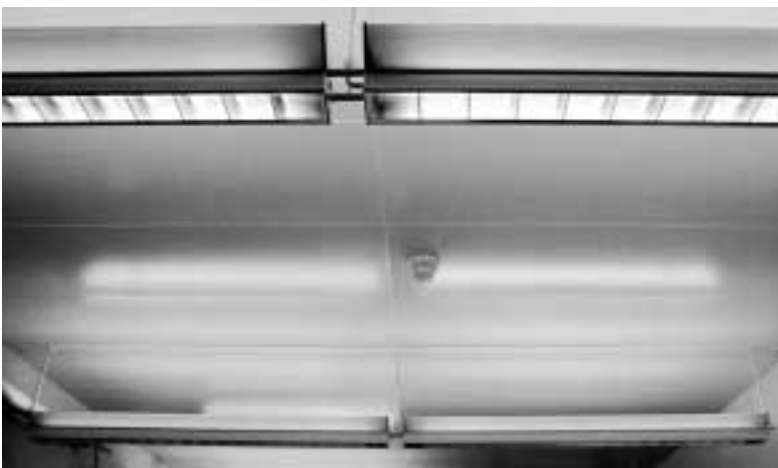
Figura 67 Lampade adatte per posti di lavoro al VDT: lampade da soffitto irraggianti luce diretta e indiretta.
