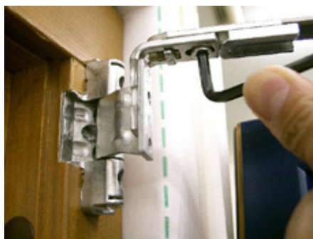
Immagine 22: Aderenza della parte superiore dell'anta (cerniera in alto)
