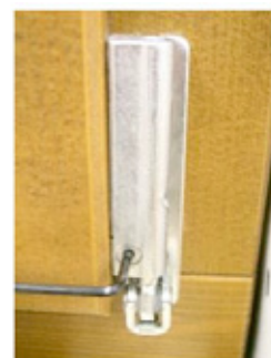
Immagine 19: Aderenza dell'anta al telaio (cerniera in basso)
