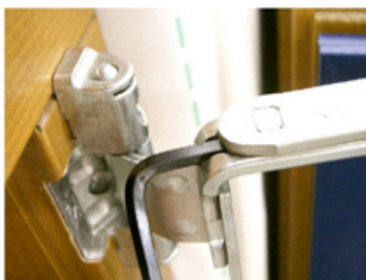
Immagine 21: Spostamento orizzontale della finestra (cerniera in alto)
