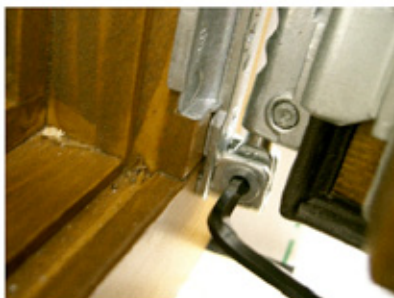
Immagine 20: Spostamento orizzontale della finestra (cerniera in basso)
