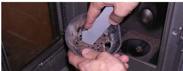
Con la punta sul lato contrario possono essere liberati da sotto i fori di aerazione della vasca di combustione. Ciò è molto importante per un'ottima combustione!
