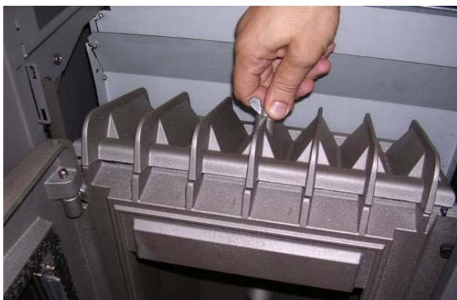
Pulire i passaggi dei gas di combustione sui pannelli della camera di combustione usando una spazzola a manico lungo. (Rüegg - Cod. N° 52.57.00510)
