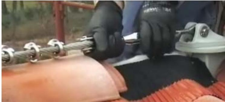
La linea risulta montata completamente in tutti i suoi pezzi. È necessario metterla in tensione agendo come segue:
