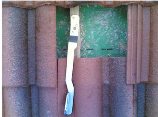
Per rendere completamente utilizzabile la linea vanno inseriti, nei punti indicati nel progetto, i punti di ancoraggio singoli che servono per consentire la risalita, giungere alla linea vita ed evitare l'effetto pendolo. Questi, come detto in precedenza, sono di diverso tipo a seconda della costituzione e conformazione della copertura: cambiano la geometria, l'utilizzo, i materiali e i fissaggi. Procedere quindi come segue:
