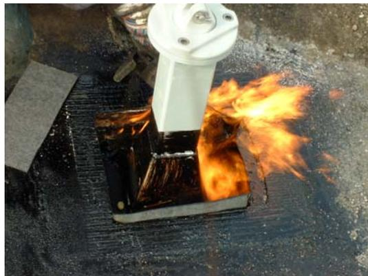
Per evitare che i supporti e punti di ancoraggio montati provochino infiltrazioni d'acqua, si deve:
