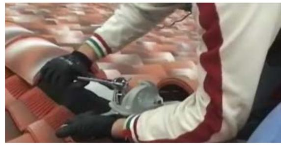
Dopo l'installazione dei supporti si procede con il fissaggio sugli stessi degli elementi d'estremità fissi art.A1 e intermedi art.A4 con gli appositi kit di fissaggi M12 a testa esagonale, come segue:
