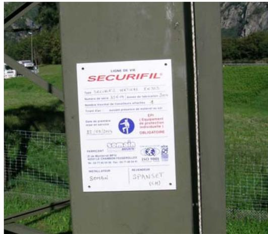
La chiusura dell'installazione si completa con il montaggio del cartello art.A0, obbligatorio in corrispondenza di ogni accesso.
