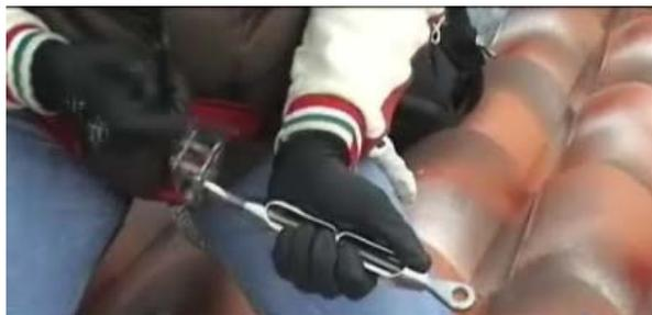
Ad una delle due estremità della linea va inserito il tenditore sull'elemento d'estremità fisso art.A1, come segue:
