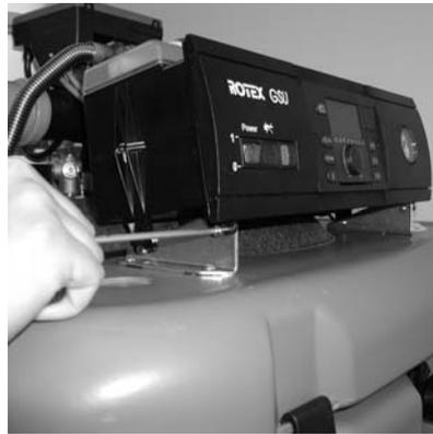
Figura 5-8 Allentare le viti di fissaggio del pannello di connessione della caldaia
