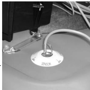
Figura 5-12 Sonda di temperatura del bollitore con molla curvata
