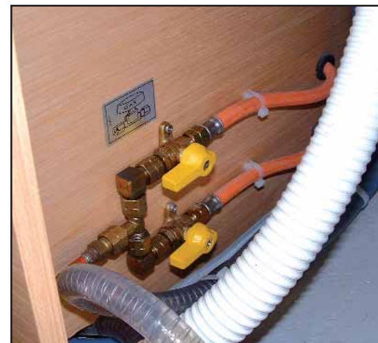
VALVOLE DEL GAS (armadietto sotto il forno)
