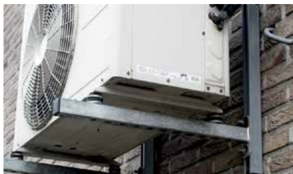
Fissaggio di staffe per condizionatore
