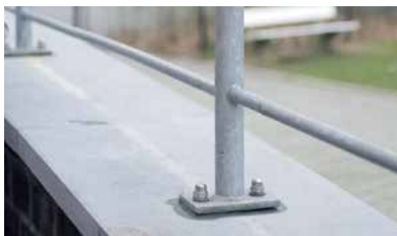
Fissaggio di parapetto
