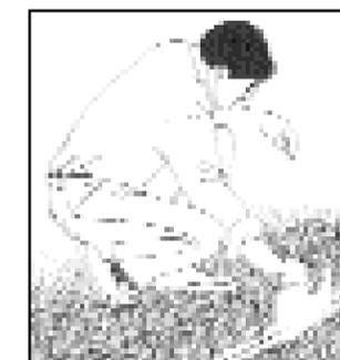
Usare delle assicelle di cedro o del cartone piegato per sistemare il cavo nel fondo del canale. Ricoprire con la terra rimossa.
