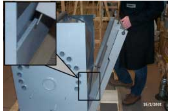
F positionner les montants sur le corps de la chaudière.
