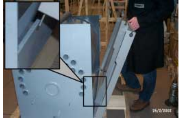
F Plaats de zijpanelen op de verwarmingsketel.
