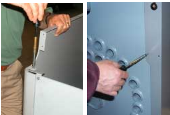
G Bevestig de zijpanelen aan de voor- en achterkant.
