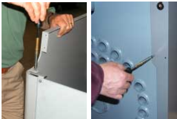
G fixer les montants antérieurement et postérieurement.
