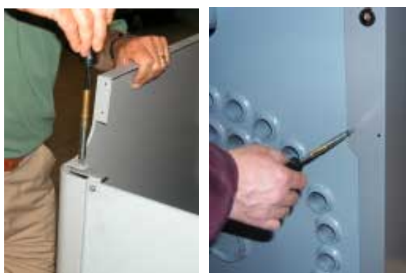
G Fixe os painéis anteriormente e posteriormente.
