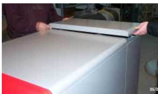
M Montér dækslerne i henhold til rækkefølgen angivet under punkt "B".
