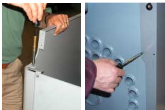
G Fissare i fianchi anteriormente e posteriormente.
