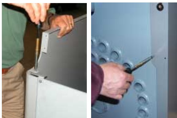
G Fijar los laterales por delante y por detrás.
