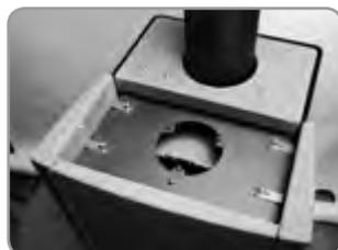
Pulite ora il tubo della stufa e il tronchetto di scarico fumi e rimuovete i residui con l'aspirapolvere. Riposizionate gli elementi nella posizione iniziale e riavvitate la lastra di metallo.
